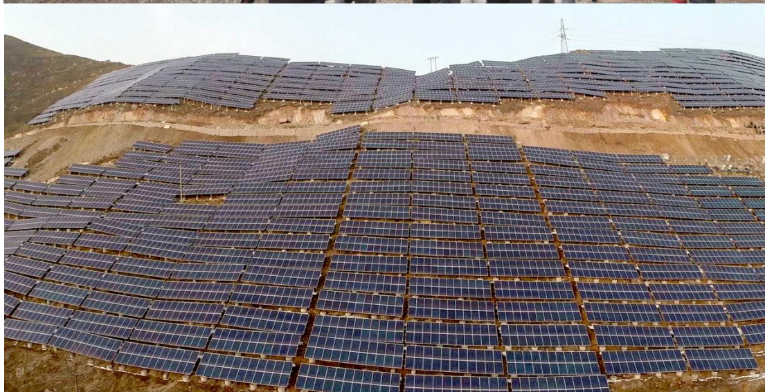
植筋基础工程实景
