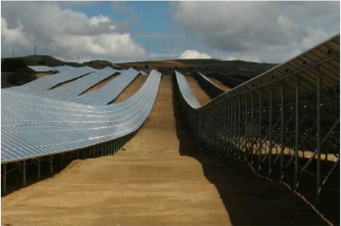
螺旋桩应用工程实景
