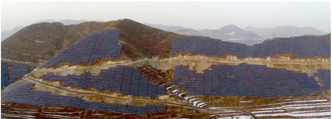
独立基础工程实景
